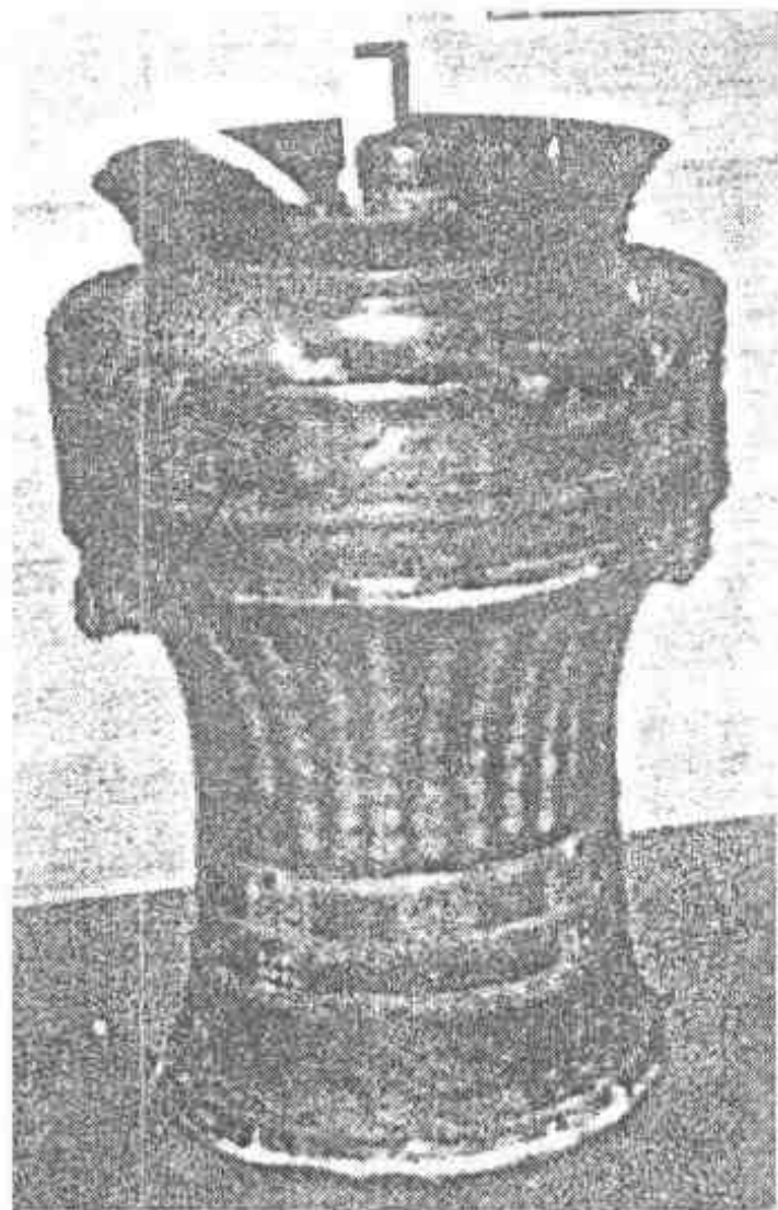
兽耳八卦篆刻铭漏壶及结构图。
