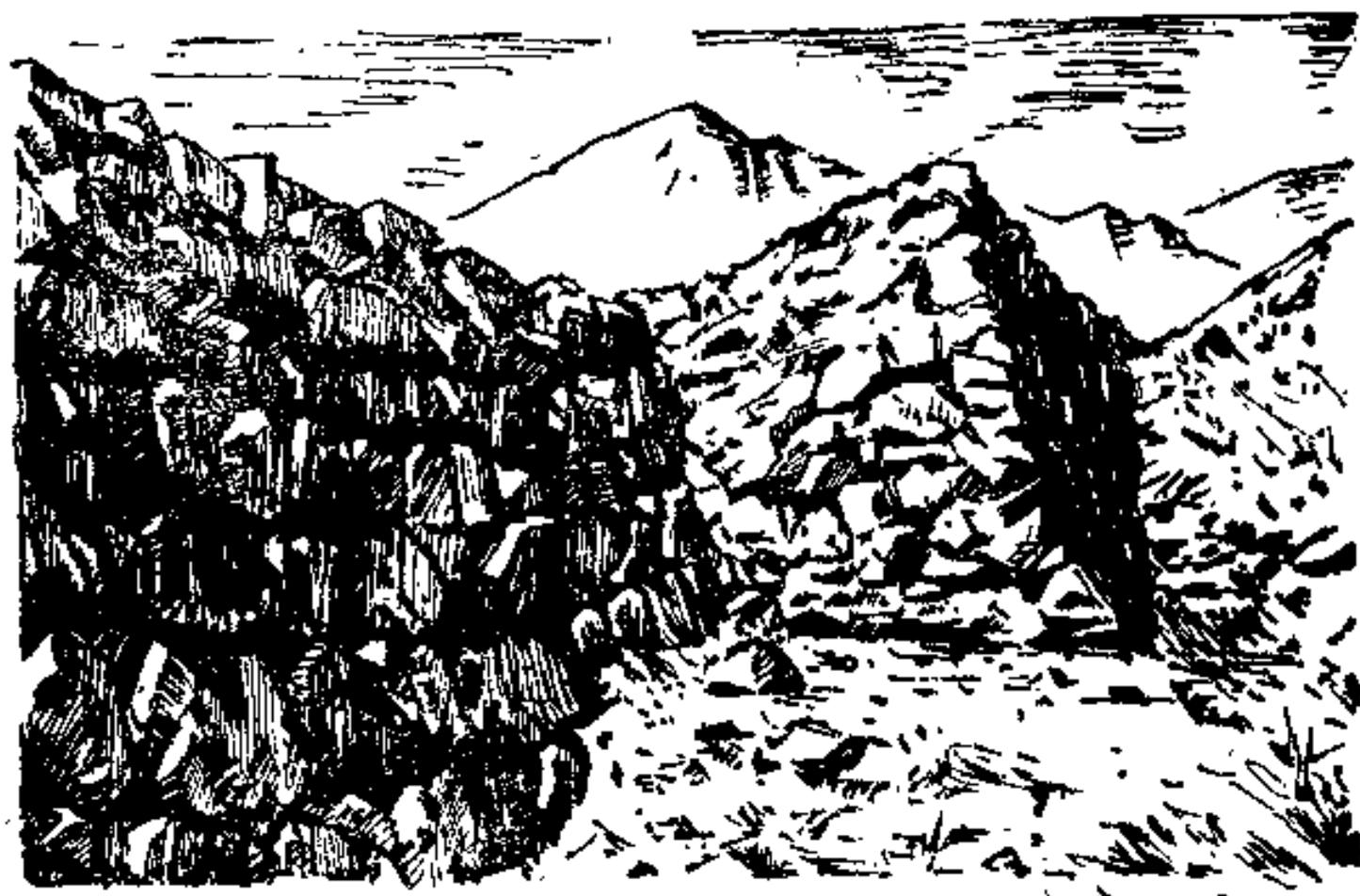
图 39 宁夏贺兰山脚下的长城水平错动了1.3米
